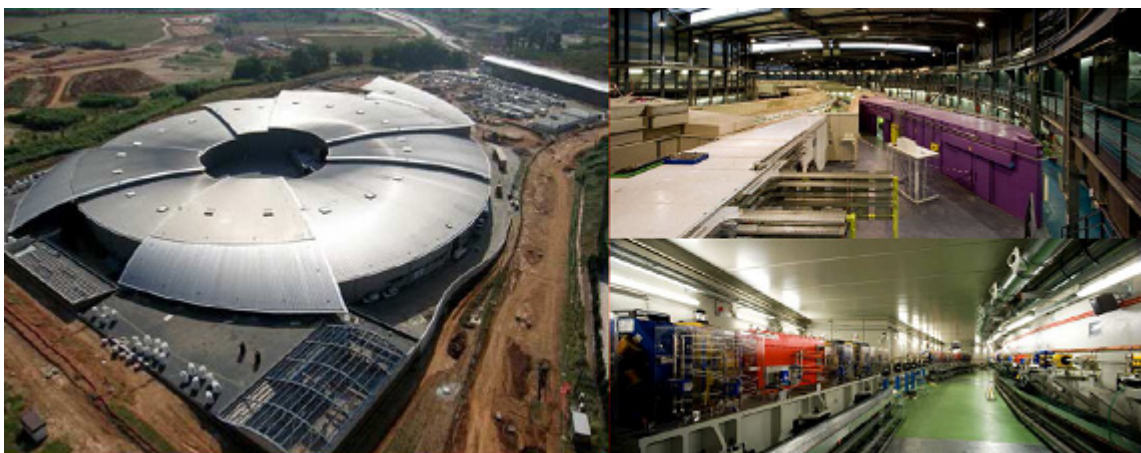
Diferents vistes de la instal·lació ALBA: vista general (esquerra); sala experimental, en la qual es pot veure una estació experimental (a la dreta superior); interior del túnel de l'accelerador, amb el propulsor a la dreta i l'anell d'emmagatzematge a l'esquerra (a la dreta inferior)
