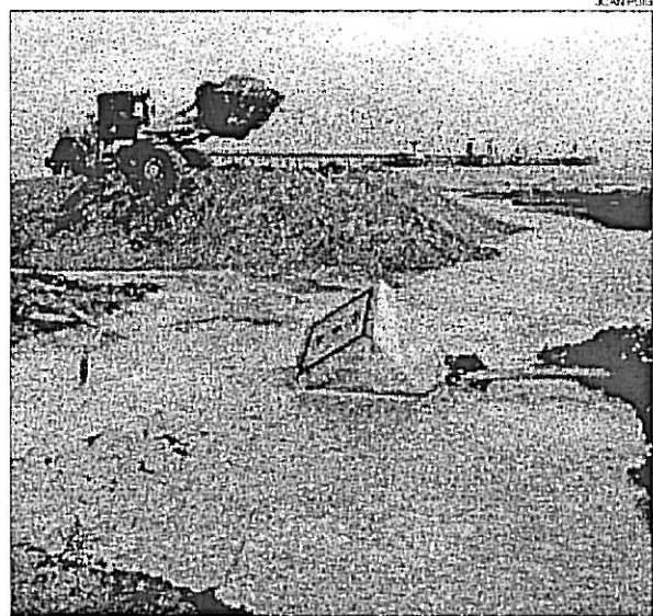
► Terrenys per a la futura zona logística del port, ahir.
