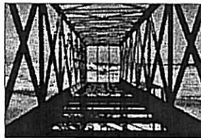
Un dels 'fingers' en construcció a la terminal Sud del Prat ■ C. CALDERER
