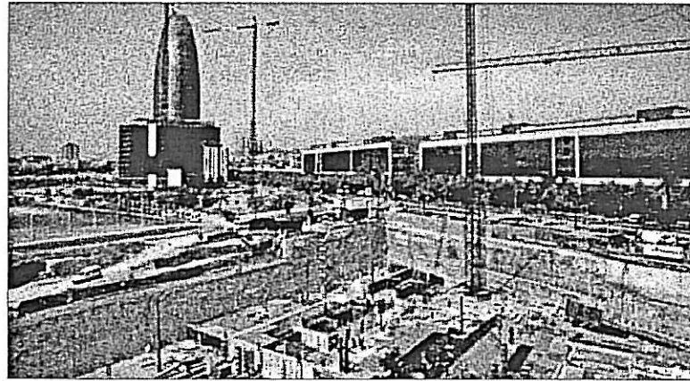
Obres de construcció del nou campus de la UPF al 22@ ■ XAVIER BERTRAL
